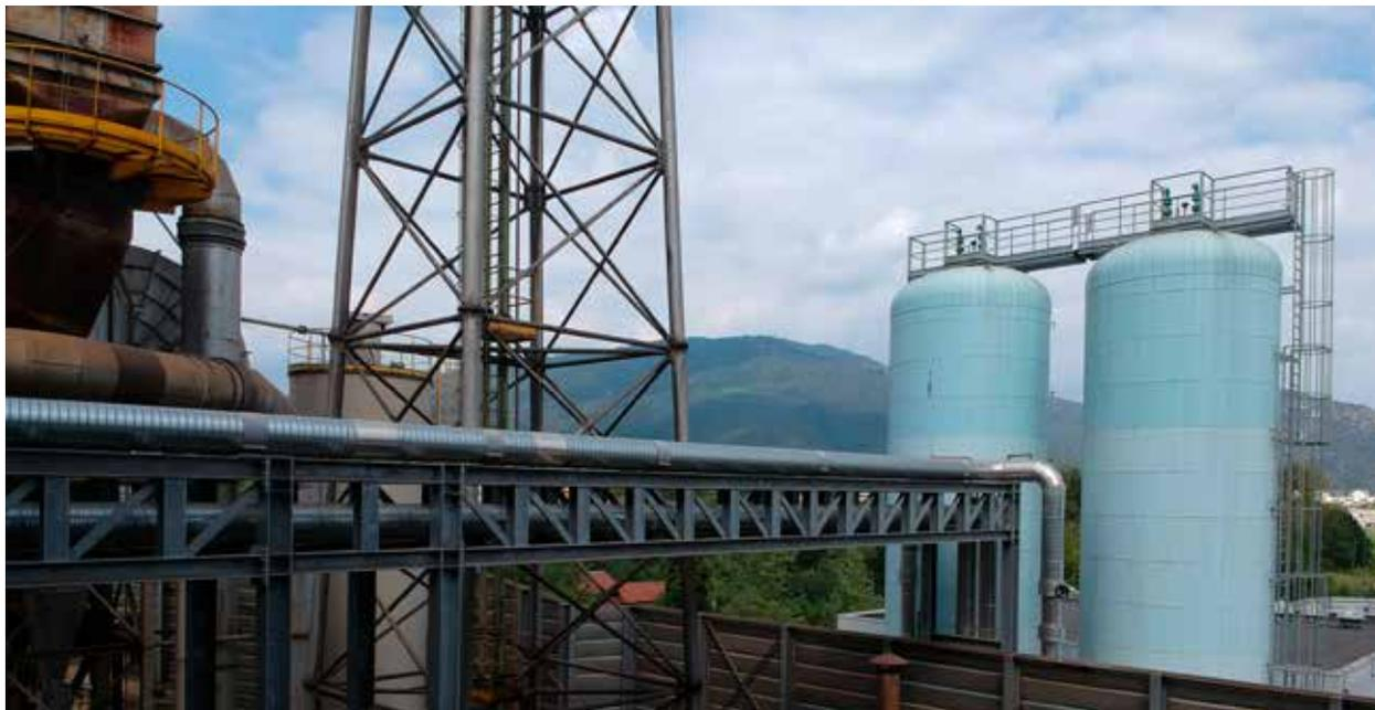
Alfa Acciai: sistema di tubazioni di alimentazione dell'impianto recupero calore dall'acciaieria e serbatoi di accumulo
